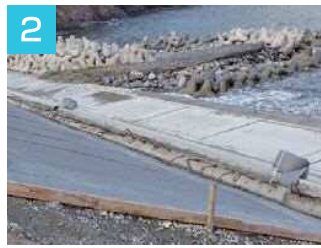
2 均しコンクリート打設
