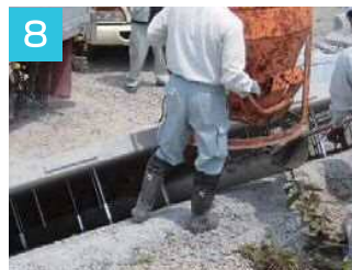
8 胴込コンクリート打設
