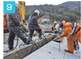
9 コンクリート締固め
