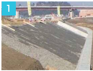
1 法面整形・基礎砕石転圧
