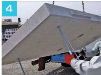
4 アンカー取付け
