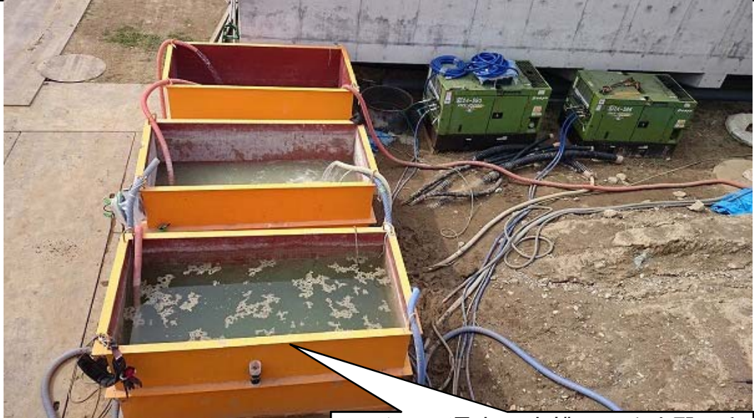
コンクリ汚濁水の水槽による沈殿工程
