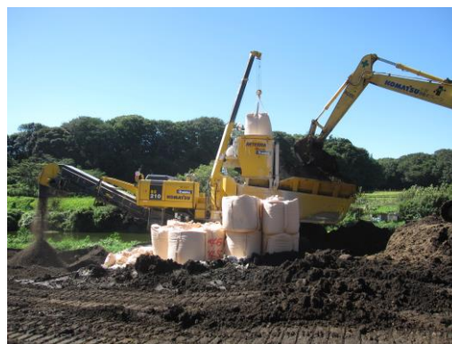
河川浚渫工事② (改良土保管場所条件が中性)
