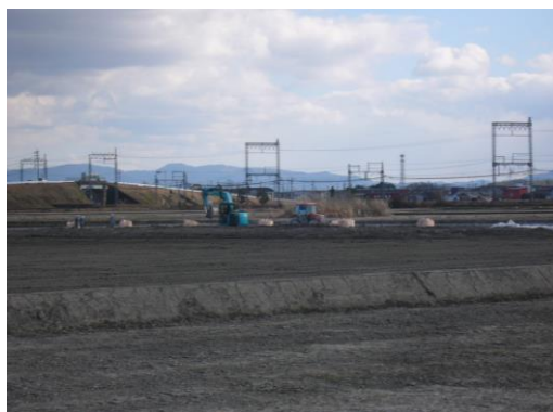
ほ場整備工事 (基盤増強の為)
