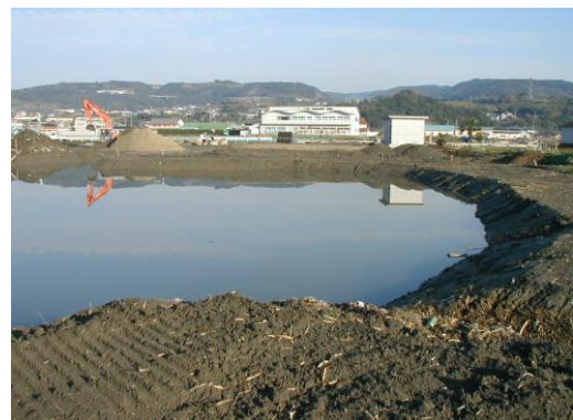
公園整備工事② (公園埋戻しや築堤材として利用)
