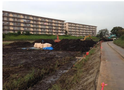
調整池浚渫工事② (浚渫土養生場所不足の為)
