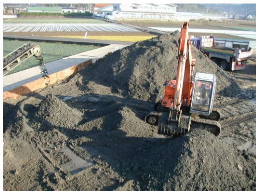
公園整備工事① (湖沼浚渫土改良状況)
