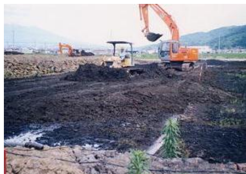
湖沼浚渫土改良工事② (改良土のほ場嵩上げ利用)
