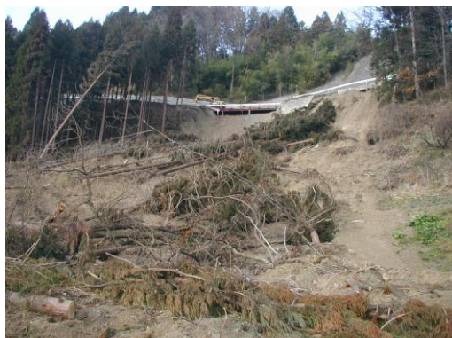
災害復旧工事① (周辺農地への配慮及び復旧後植栽の為)
