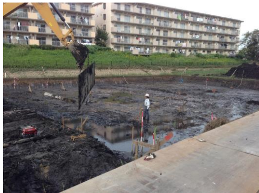
調整池浚渫工事① (浚渫土養生場所不足の為)
