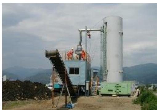
湖沼浚渫土改良工事① (改良土のほ場嵩上げ利用)
