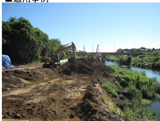
河川浚渫工事① (改良土保管場所条件が中性)
