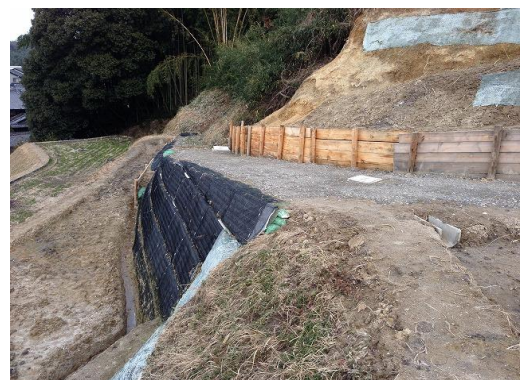
災害復旧工事 (農道路体材として利用)
