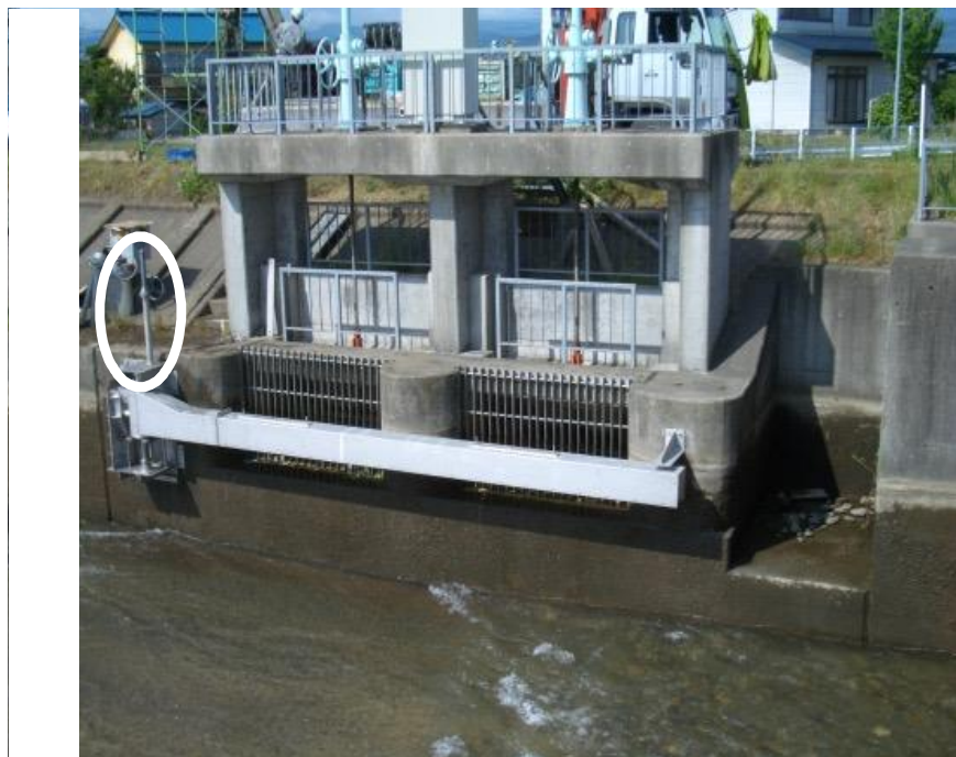
図2 洪水時の閉じた状況(丸印:ジャッキ)
