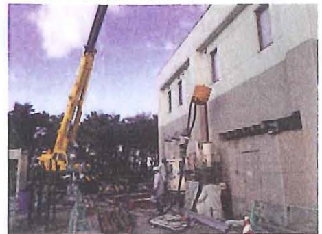
写真-3 施工状況
