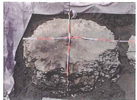
写真-2 改良体出来形 (シルト地盤)
