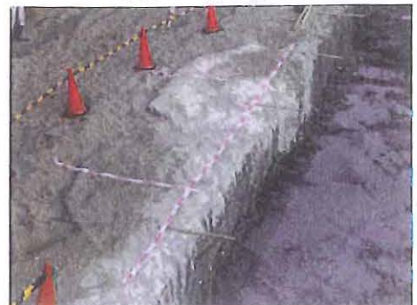
写真-4 掘削時の出来形確認状況
