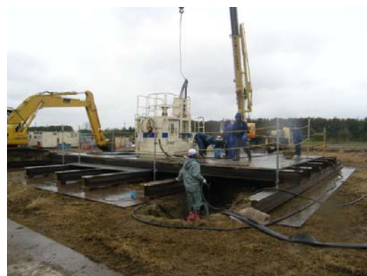
写真-1 実大実験における施工状況
