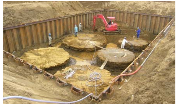
写真-2 改良体掘り出し状況
