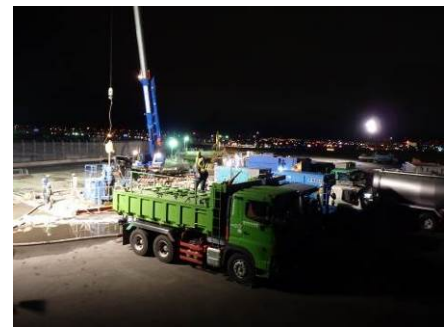
写真-1 施工状況
