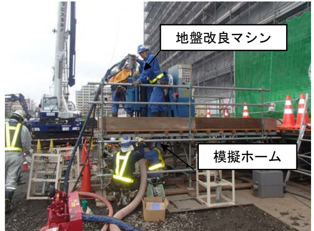
図5 試験施工状況(地上部)
