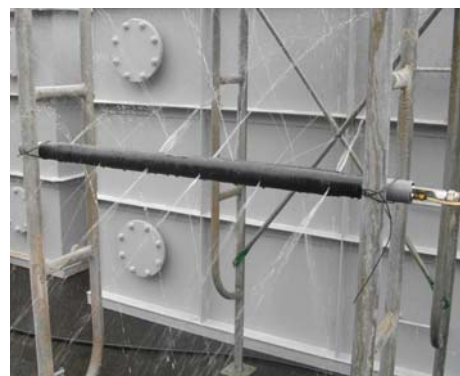
写真-2 新型注入管の気中吐出状況
