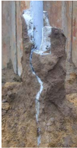
写真-7 一次注入材注入状況
