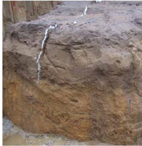
写真-8 一次注入材注入状況
