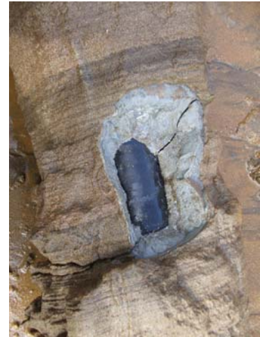
写真-9 注入管周囲の砂の固結状況
