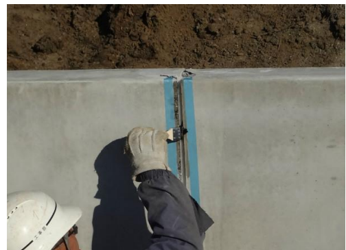
シーリング材充填の準備工(2)
