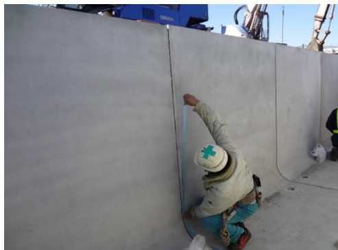
シーリング材充填の準備工(1)
