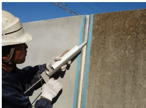
シーリング材充填工
