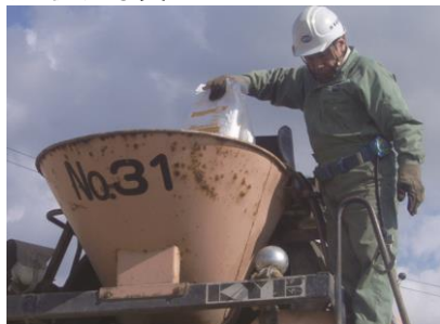
投入状況写真
