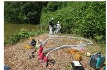
③ 機材はすべて人力で設置
