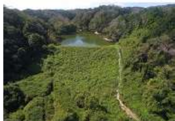
① 車両が進入できない現場
