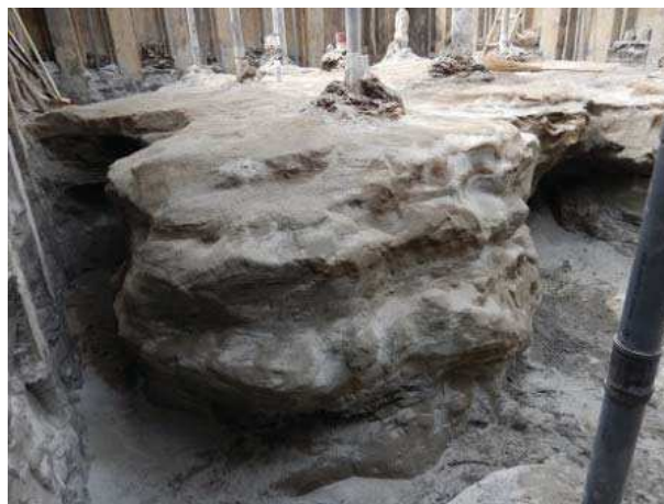
図-13 改良体状況 (Case Dp-1)
