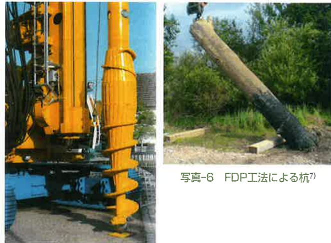
写真-5 FDP工法の施工機械 7)
