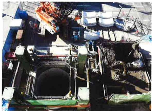
写真-7 コンパクトな作業ヤード
