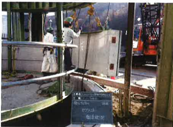
写真-5 アーバンライナー®組立状況
