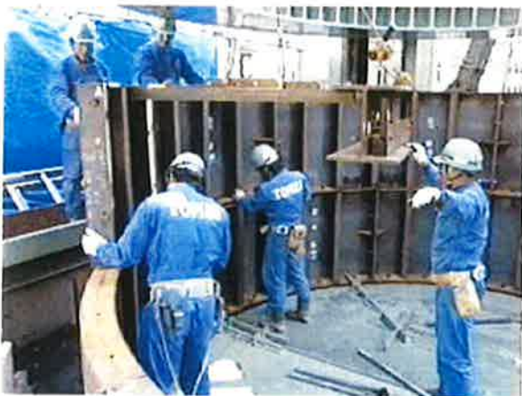
写真-4 アーバンリング組立状況
