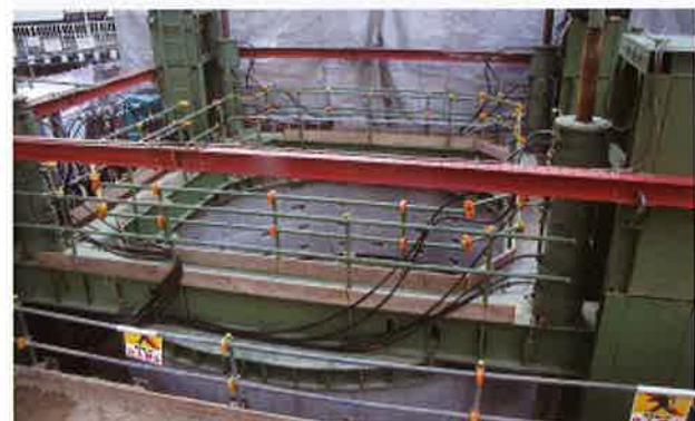
写真-4 RCアーバンリングの圧入
