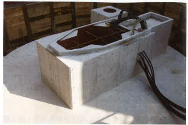
写真-8 頂版コンクリート打設
