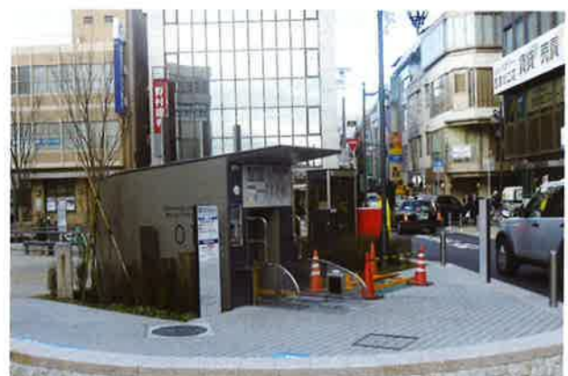
写真-10 地上部の入出庫設備
