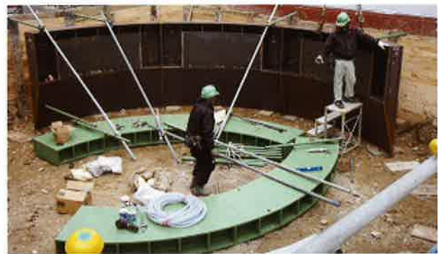
写真-2 刃口リングの据付
