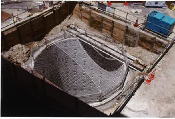
写真-5 RCアーバンリング施工完了
