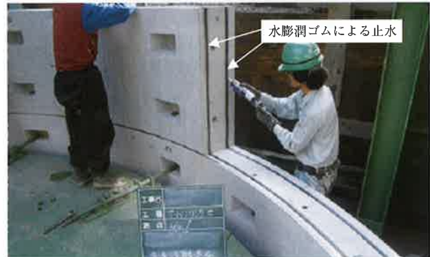
写真-3 RCアーバンリングの組立
