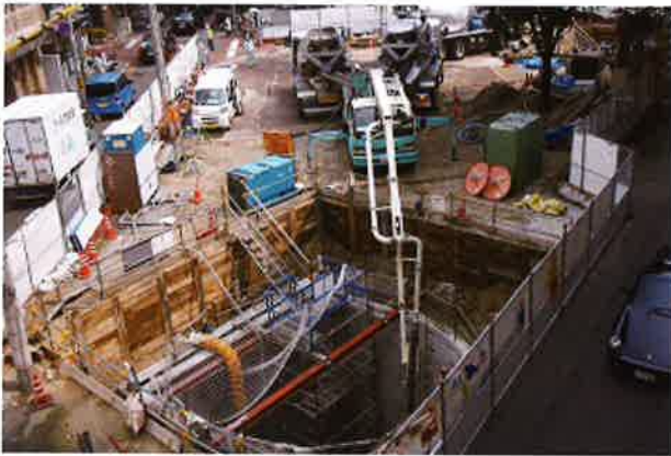
写真-6 底版コンクリート打設
