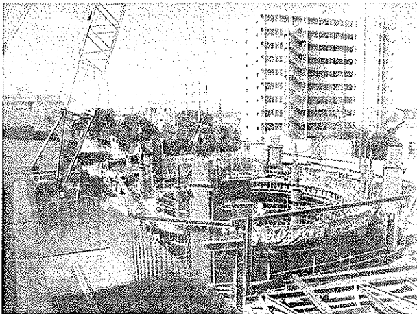
写真-3 大口径アーバンリング施工状況
