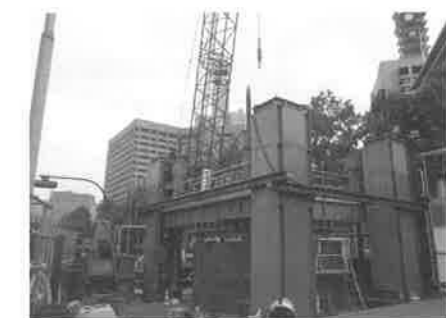
写真-3 施工状況
