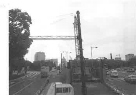
写真-2 施工ヤード
