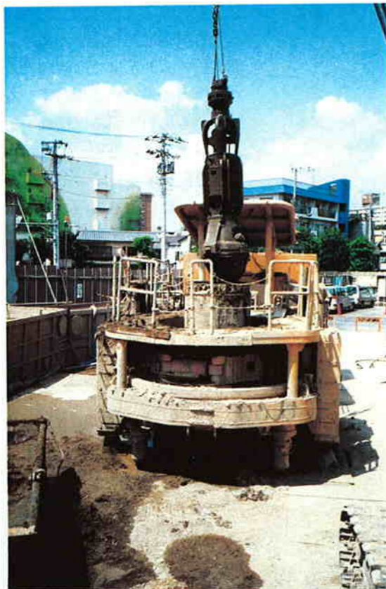
写真-6 砂置換工法施工状況
