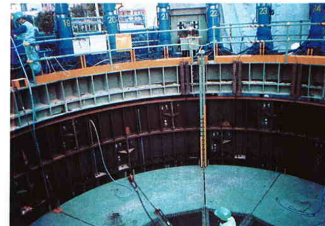
写真-4 セグメント組立完了
