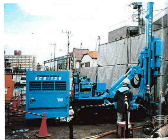
写真-8 グラウンドアンカー施工状況(パイブレーションドリル)
