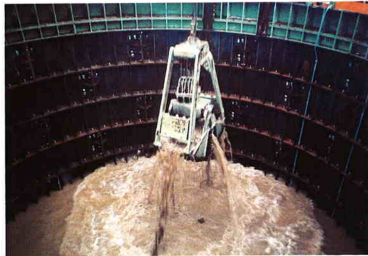
写真-9 掘削状況
