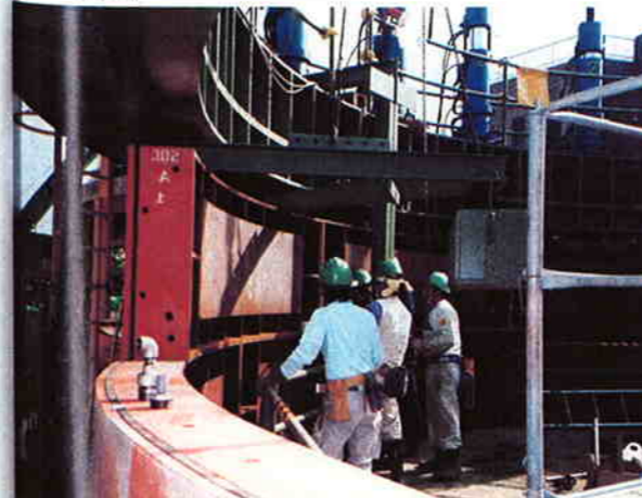
写真-3 セグメント組立状況
