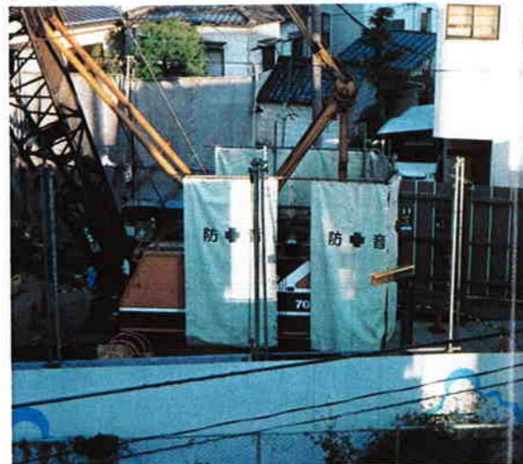
写真-7 砂置換工時の防音対策
