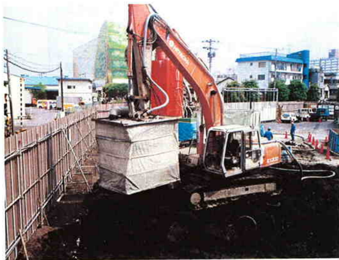
写真-6 浅層混合処理工
