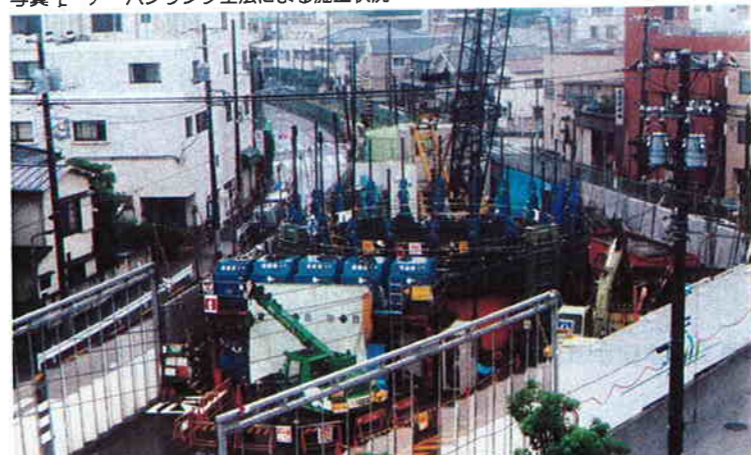
写真-2 アーバンリング工法による施工状況
