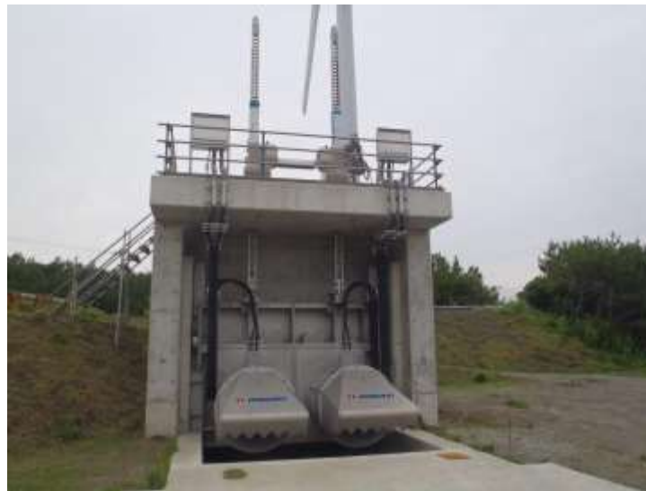
施工実績写真 - 1
