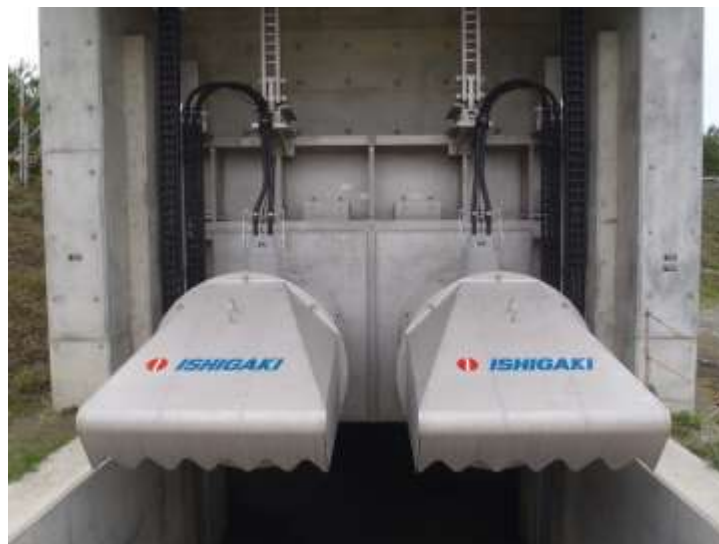
施工実績写真 - 2
