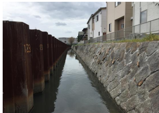
河川改修工事 施工後
