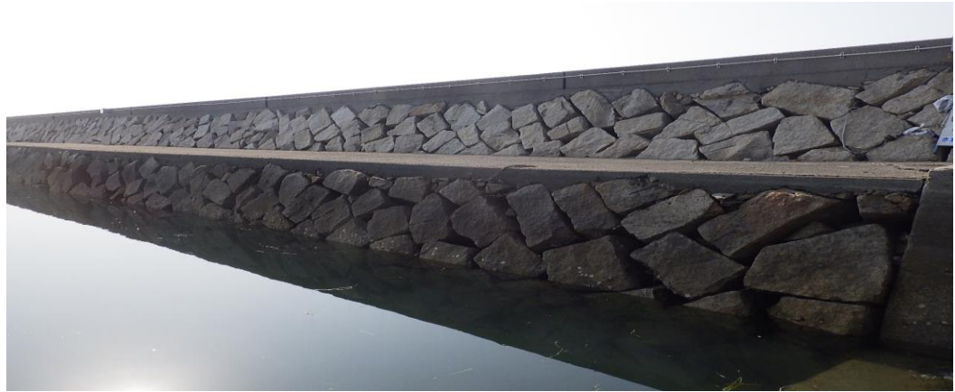
防波堤機能保全 施工
