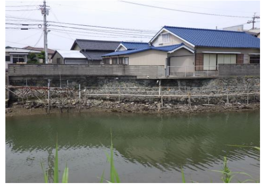
護岸修繕業務 施工後
