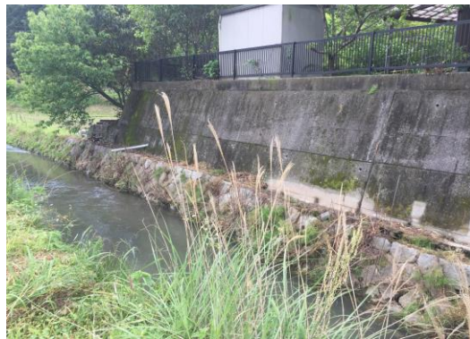
河川災害復旧 施工全
