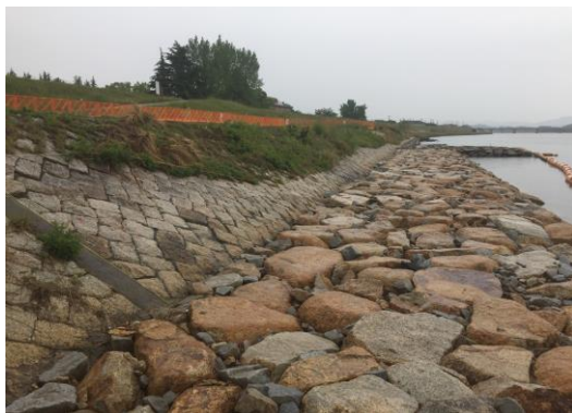
河川改修工事 施工後
