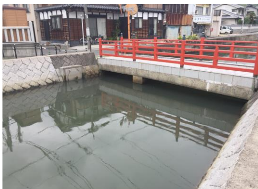
景観保全整備 施工後
