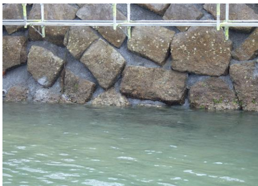
防波堤機能保全 施工
