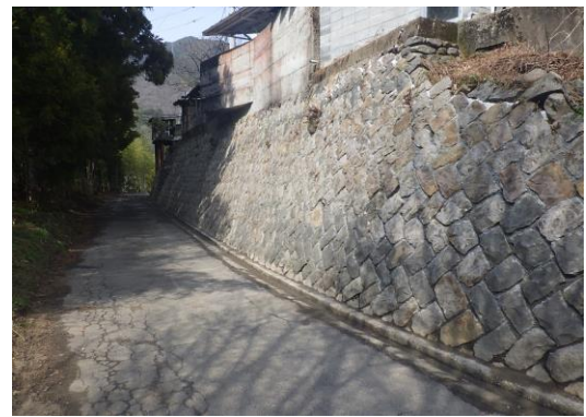
景観保全整備 施工後
