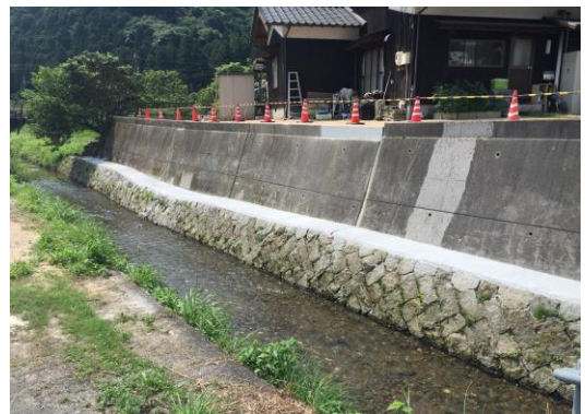
河川災害復旧 施工後
