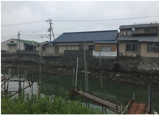
護岸修繕業務 施工全
