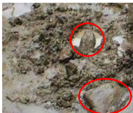
図 4.1 基床面に残置された転石
