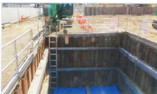
浄化槽設置工事現場事例
