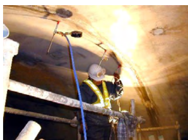
ひび割れ高圧注入
