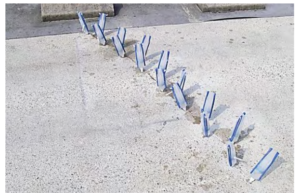
漏水補修（低圧注入）状況：駐車場
