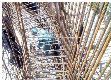
打継ぎ部処理（水平打継ぎ部）
