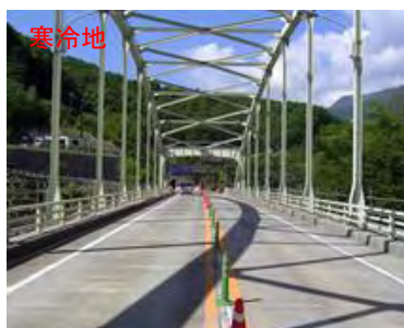
寒冷地 既設床版(コンクリート舗装)の凍害対策
