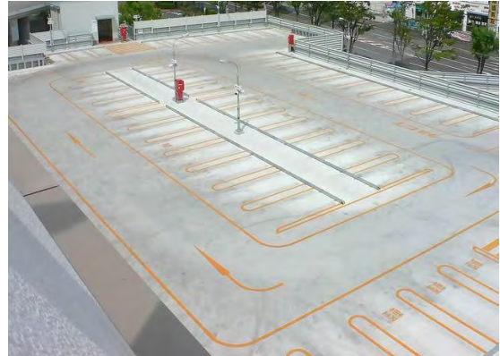
立体駐車場防水
