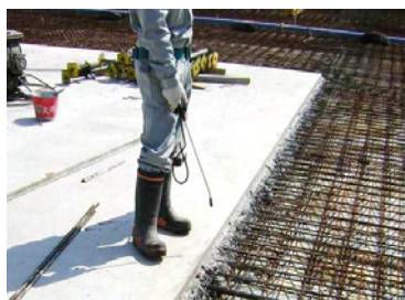
打継ぎ部処理（鉛直打継ぎ部）
