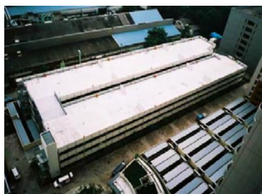
立体駐車場防水
