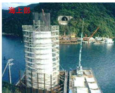
海上部 新設橋脚の塩害対策
