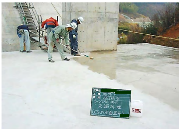
橋台上面：CS-21塗布状況
