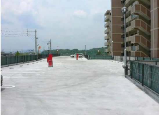
立体駐車場防水
