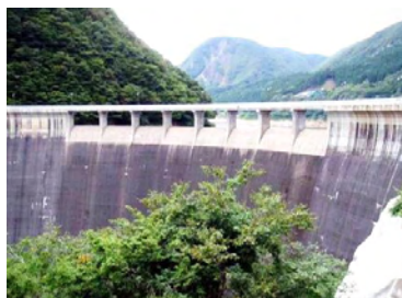
ダム（堤頂・越流部）表面保護
