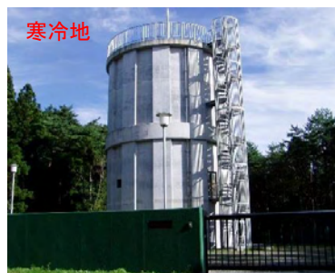
寒冷地 既設配水塔の長寿命化対策
