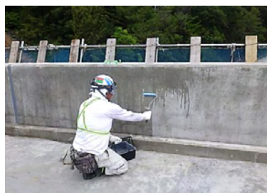
横向き塗布 (壁高欄)
