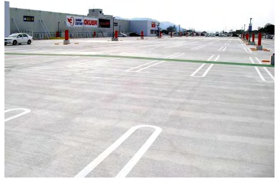
屋上駐車場防水
