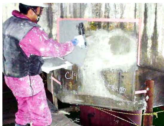
断面修復状況
