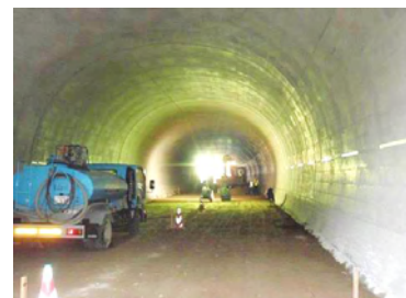
トンネル覆工部 表面保護
