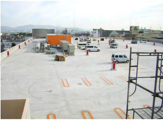
屋上駐車場防水
