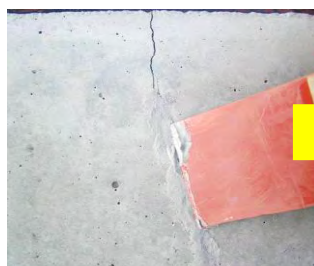
CSパテすり込み状況
