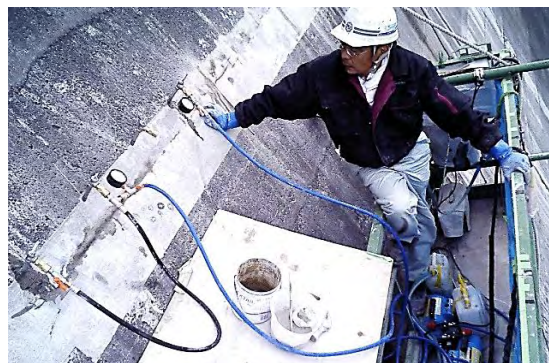
漏水補修（高圧注入）状況：ダム
