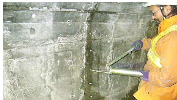
漏水補修（高圧注入）状況：水路トンネル
