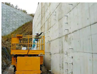
ひび割れ補修：橋台
