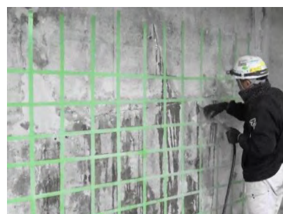
漏水補修：地下室
