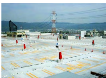
屋上駐車場防水
