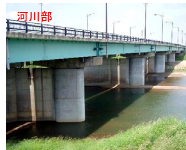
河川部 橋脚巻立て部のひび割れ対策
