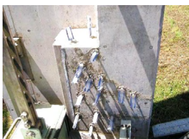
ひび割れ低圧注入
