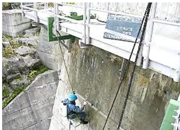
ダム堤体下流面：CS-21散布状況
