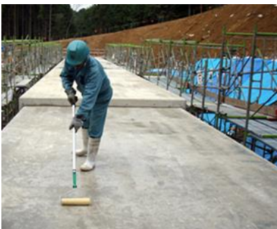
新設：ボックスカルバート
