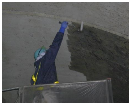
新設：トンネル
