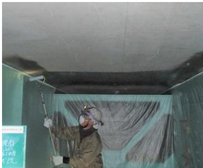
既設：床版下面
