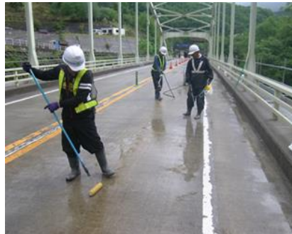
既設：床版上面(コンクリート舗装)
