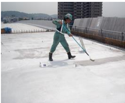
新設：床版上面
