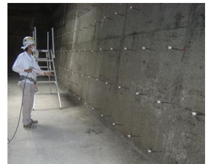
既設：配水池(増厚部)
