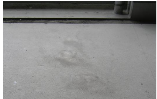
写真 1-4 施工後 水張り直下部 48 時間後
