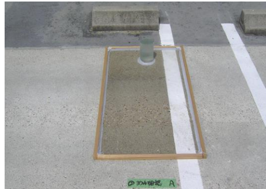
写真 1-2 施工後 水張り状況
