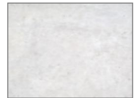
⑤乾燥状態 塗布：不適 (散水が必要)
