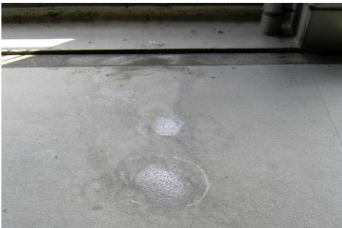
写真 1-3 施工前 水張り直下部 20 時間後
