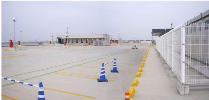
屋上駐車場全景
