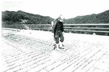
写真2 けい酸塩系表面含浸材散布
