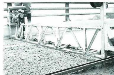
写真3 高精度打設機
