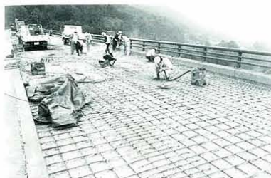
写真1 コンクリート劣化部除去
