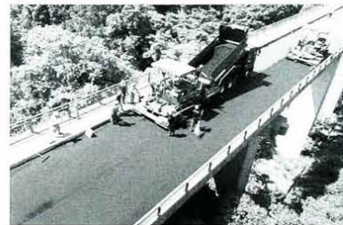
写真4 アスファルト舗装
