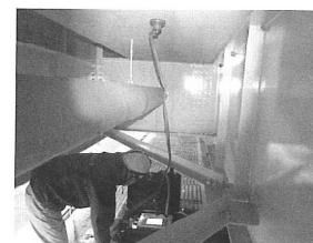
写真4 表層透気試験状況
