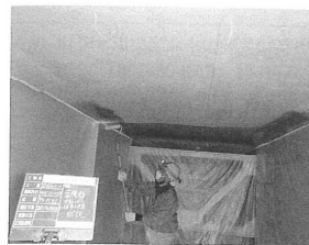
写真2 材料塗布状況
