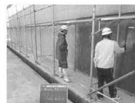
写真-5 表面含浸材塗布：2回目(被覆面)
