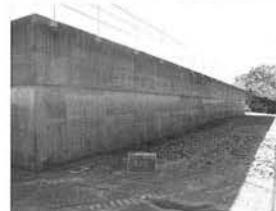
写真-1 全景(施工前)
