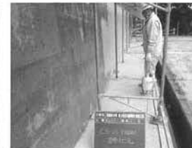
写真-3 表面含浸材塗布：1回目(躯体面)
