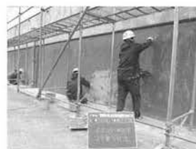
写真-4 表面被覆材こて塗り
