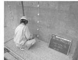
写真-2 ひび割れ注入(バルーン式)
