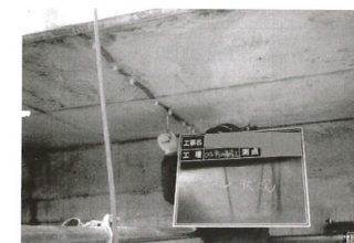
写真3 注入工法 シール状況
