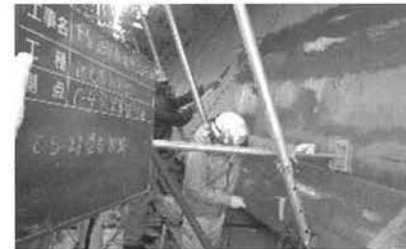
写真-2 施工状況
