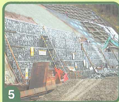
中詰材の投入
