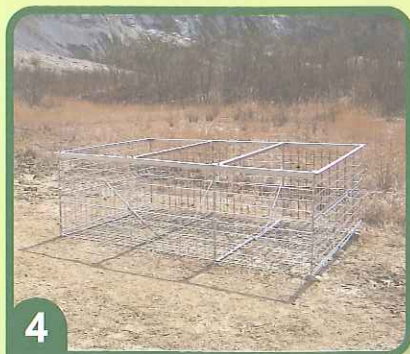
側面枠の取付
